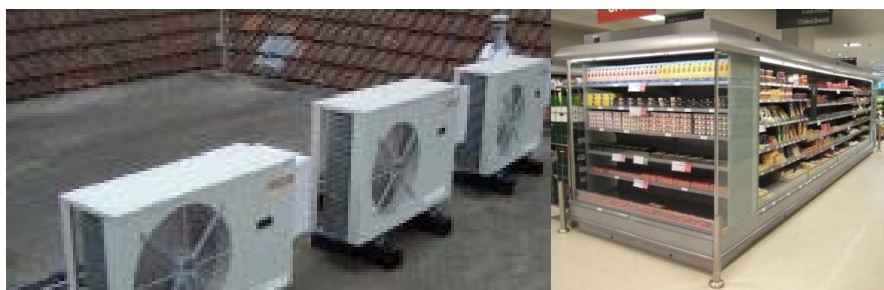
Figuur 13, Voorbeelden van supermarktininstallaties die gebruik maken van koolwaterstoffen
