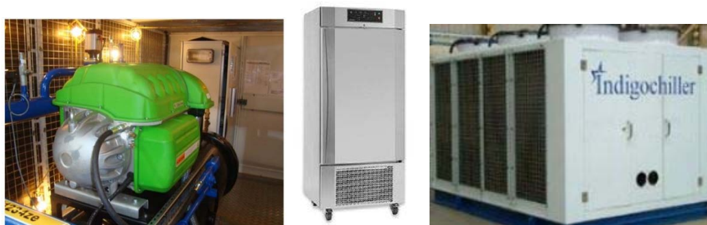
Figuur 12, Voorbeelden van apparatuur die is ontworpen om R1234ze te gebruiken
